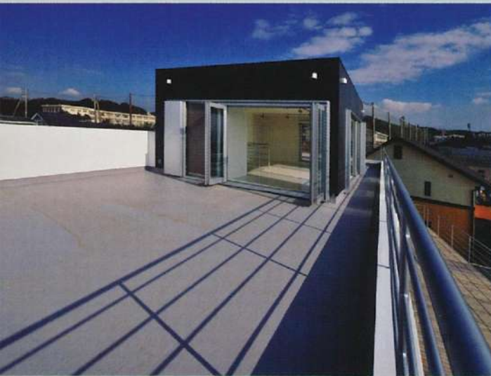
3階とそこから続く屋上バルコニーはY邸のエクストラスペース。デッキとはまた違ったアウトドアリビングとして楽しめる。「3階はいずれ書斎として作り込んでいてもいいかな」(Yさん)
