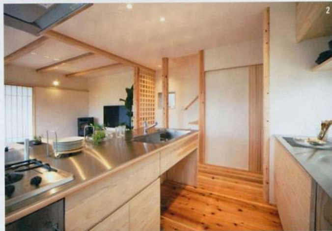
1. リビングからキッチン側を見たところ。左手の格子は釘を1本も使わずに手作業で組まれた伝統的な面格子で、耐力壁の役割も果たしている 2. 天板に厚さ3mmのステンレスを使用したオリジナルキッチン。「作業スペースが広くて使いやすいです」と妻
