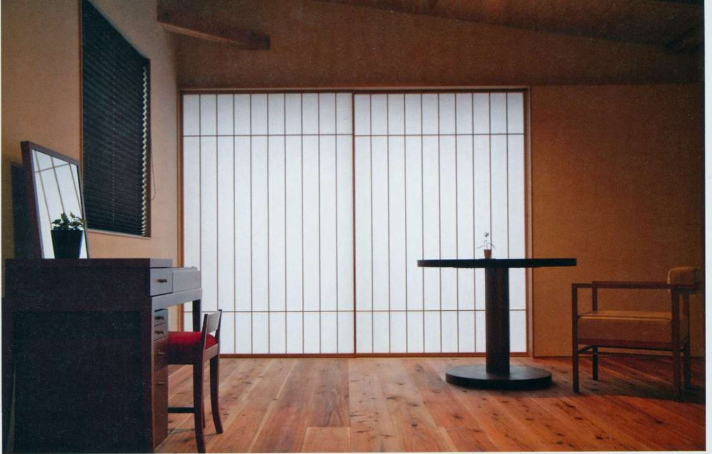
1、2階とも南側の窓には障子を設置。「障子を閉めると、冷暖房の効率が2〜3℃アップします」と山本さん。棧を細くしてモダンな雰囲気
