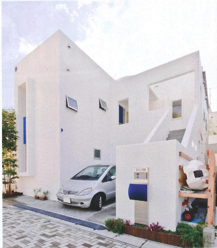
地中海のリゾート邸宅をイメージした外観。ワイズオリジナルの外壁で、汚れを付着しにくくする工夫をしている。Kさんこだわりのシーカヤック置き場も職人の手づくり
