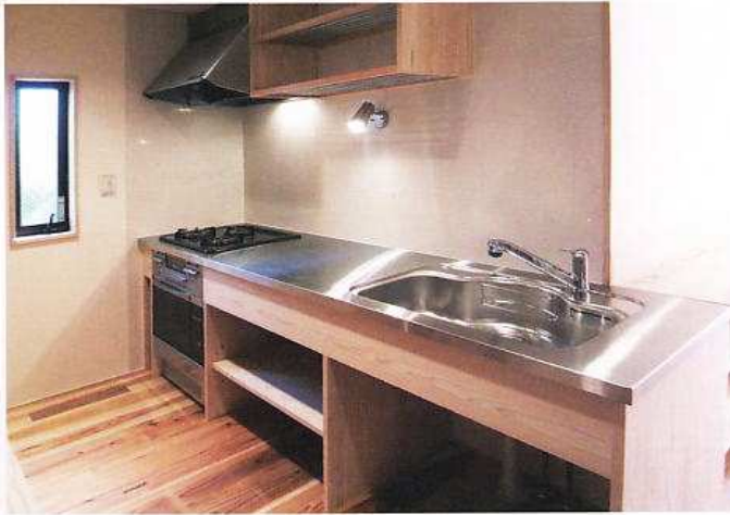
目地をなくしたタイル壁
