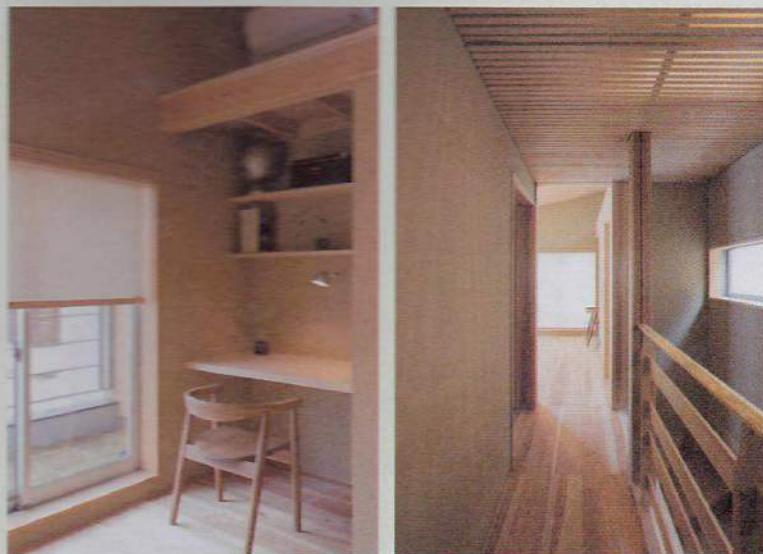
左：2階ホールのスタディコーナー。 右：吹き抜けから上がってくる熱を逃すため、階段上部の天井の格子の中に開口部を設けた。格子にすることによって機器類を設置できるだけでなく、光が美しく差しこみ、風も流れる。
