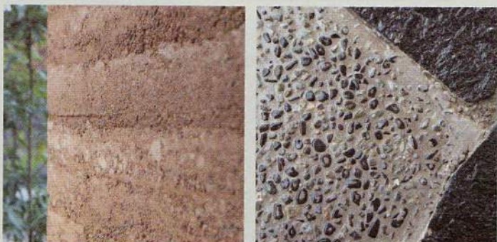
上・下左：層が美しい版築の外壁。左官職人だけでなく、いろいろな人たちが参加しワークショップ形式でつくりあげたそう。 右：洗い出しの玄関ポーチ。
