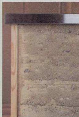
右：キッチンを中心は、カウンターの側面を版築で仕上げた「版築ヒーター」。 左上：階段下のスペースを生かしたキッチンの収納。 左下：版築ヒーターのクローズアップ。
