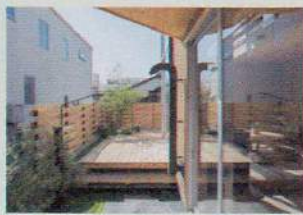
ポーチからデッキを見る。
