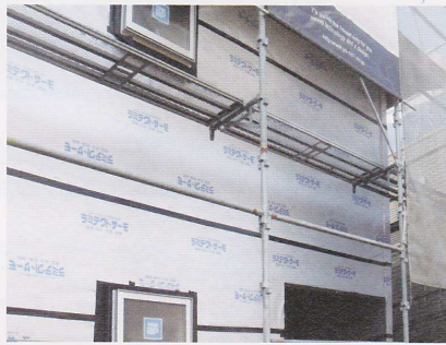
テープを貼らない施工はシートとシートに微少でも隙間が生じ、湿気の流入が起きる。施工レベルがとても重要
