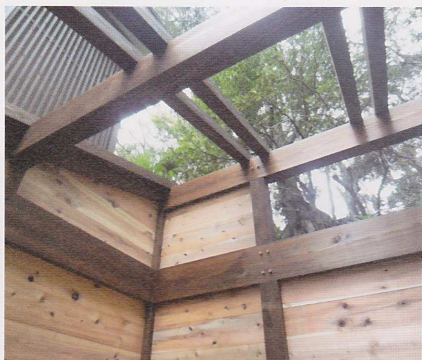
断熱材が入っていない伝統工法の家
